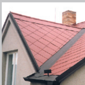
eternitová krytina po nátěru
