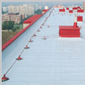
krytina po nátěru
